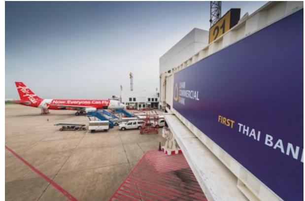
สะพานเทียบเครื่องบิน
